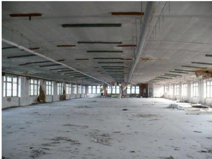
Abb. 2: Hempelsche Fabrik, Blick in die trägerlose Produktionshalle des Gebäudes 7 (c) Stadt Plauen
