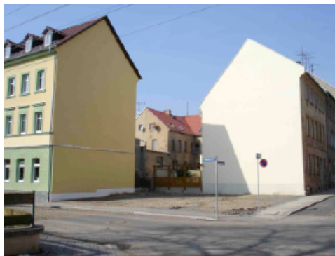
Abb. 2 Falsch verstandene Revitalisierung ... Zerstörung des städtebaulichen Ensembles; Foto: B. Brandstetter
